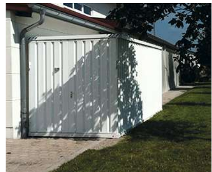
SC3000 als Lagerraum im Garten
