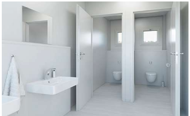
Hochwertige Sanitärinstallationen (Einbauten Unterputz)
