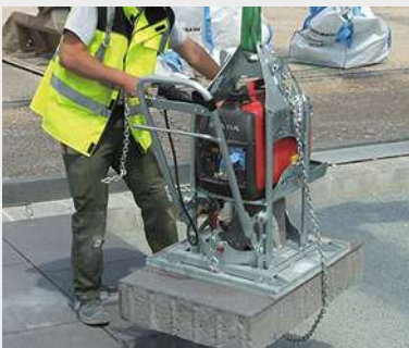
QUICKJET QJ-600-E Vakuum-Anbaugerät selbst stark poröse Elemente bis 600kg sicher ansaugen & verlegen.
