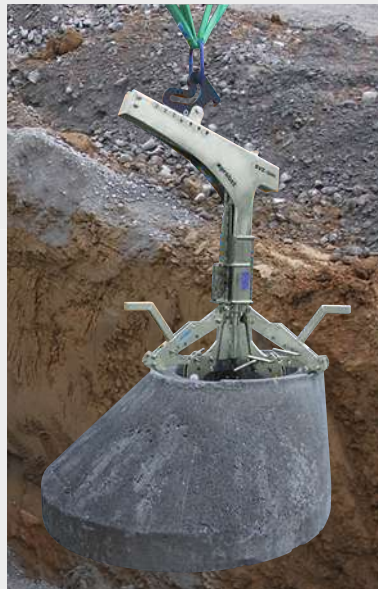
Schachtversetzzange SVZ-UNI- VARIO Waagrecht verlegen dank Schwerpunktausgleich.
